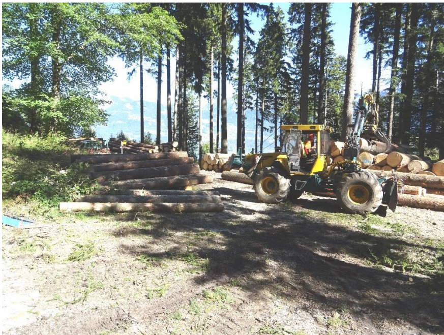
Bereitgestelltes Konstruktionsholz für den Neubau Schulhaus Feld
